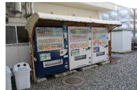
【校務員室棟北側設置現況】
