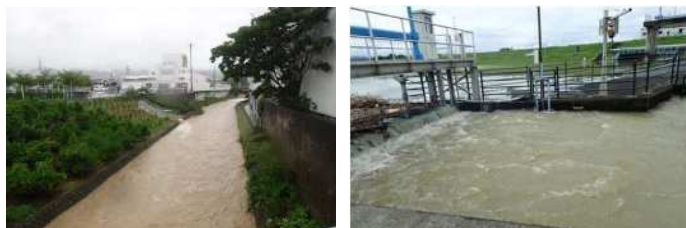
農業用の用排水路の増水状況
