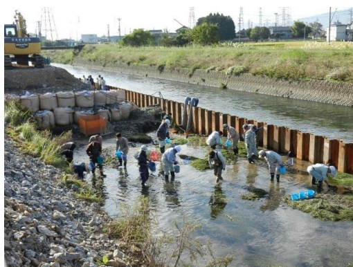
工事中の生物保護活動（杭瀬川）
