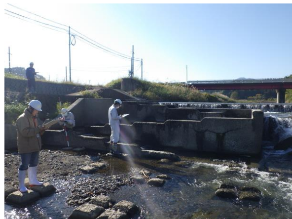
フィッシュウェイポーターによる魚道点検の状況
