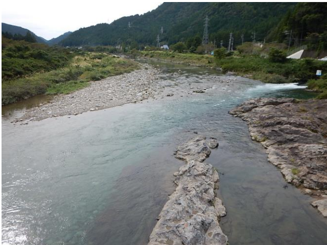
下洞戸橋上流
