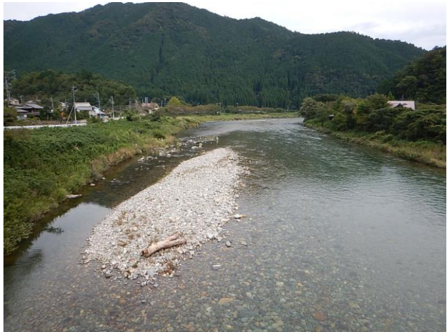
下洞戸橋下流
