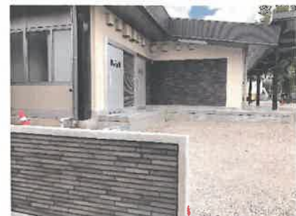
【当社製品が使用された 多治見市内の施工現場】
