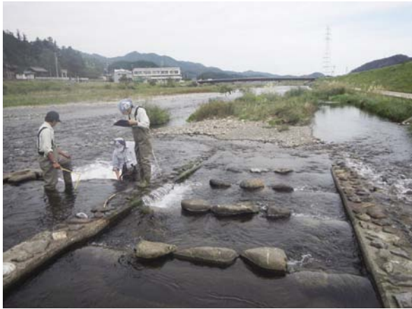
FWSによる魚道点検状況【左：武儀川(山県市) 右：日吉川(瑞浪市)】
