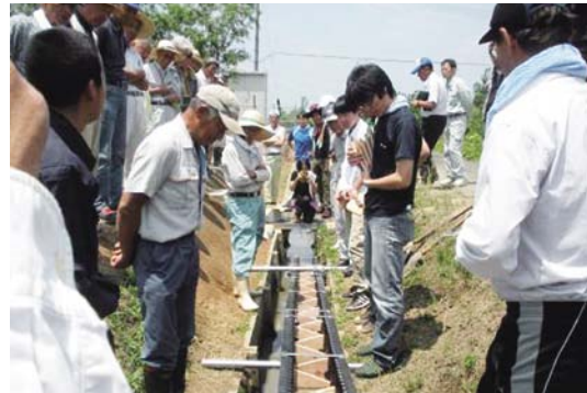
現場研修(参加者による魚道の設置)
