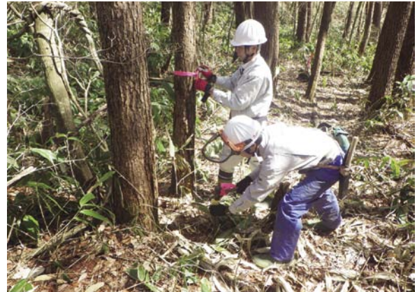
現地調査(杭打ち作業)
