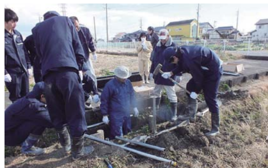
現場研修(生徒による魚道の設置)
