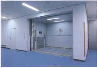
搬入用エレベーター
