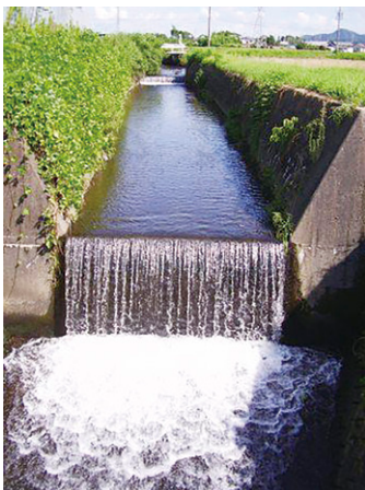
農業用排水路内の落差
