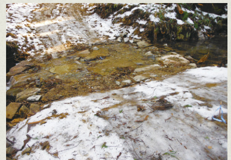
写真1 自然石を利用した洗越工
