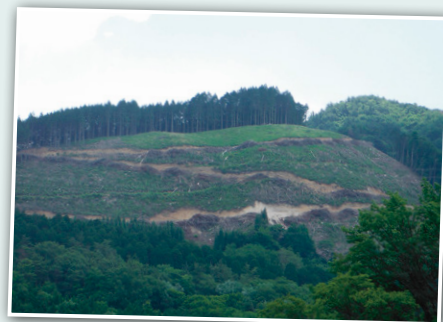
▲皆伐現場全景
