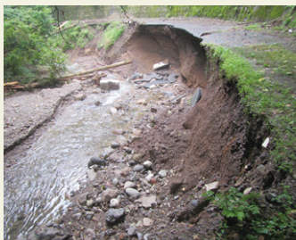
横祖線の路肩崩壊
