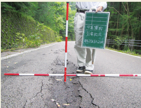
中濃線の舗装(路盤)破壊
