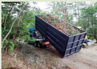
未利用端材等搬出状況(中津川市)
