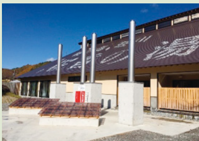
温泉施設ボイラー(高山市)
