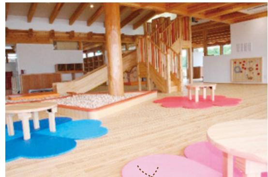
②構造・内装材は100%県産材を使用。 施設の中央の柱にΦ400のスギ丸太、 床にスギの無垢材を使用。
