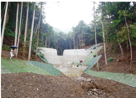
▲勢至南谷治山堰堤現場
