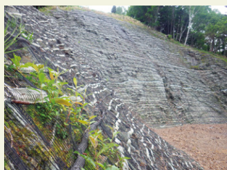
写真5 施工後2年経過した状況
