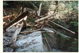
平成30年7月 豪雨災害による山地災害の状況
