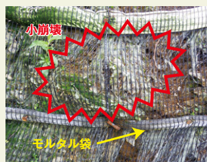
写真1 小崩壊防止状況
