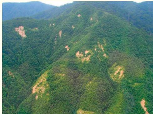
平成30年7月豪雨による山腹崩壊（川上国有林）
