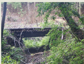
支障木を用いて架橋
