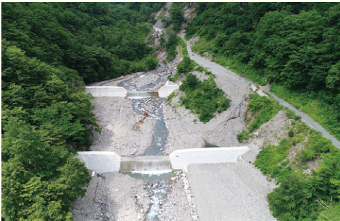
▲ H30.6月豪雨による治山施設の被災確認 (関市)
