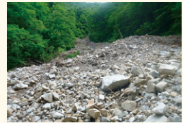
令和元年6月 豪雨災害による山地災害の状況
