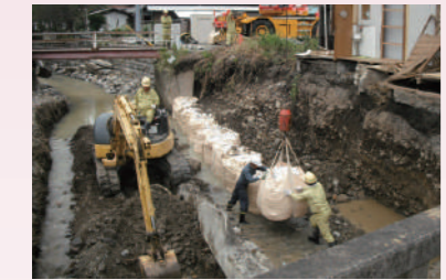
▲家屋の流出を防止するための護岸応急復旧作業
