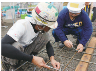
工具「ハッカー」を使い、鉄筋を結束する作業に挑戦しました
