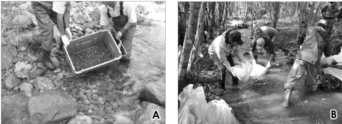
図1 人工産卵河川における砂利の運搬及び敷設作業
