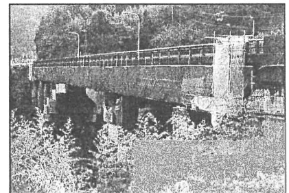
計画に基づく補修(橋梁)
