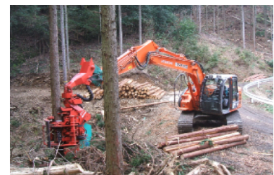
作業システム化が進む現場
