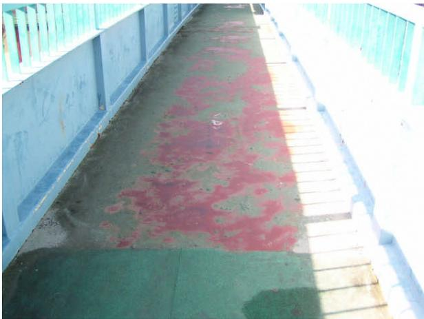
上部構造の床鋼板の露出
