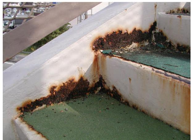
階段蹴上げ、踏み板の腐食
