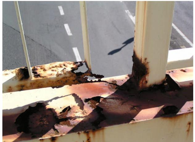
支柱、中貫および飾板の腐食
