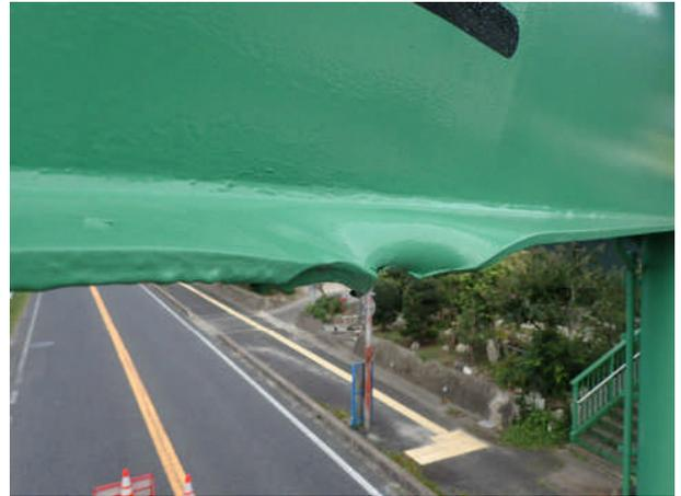
下フランジの大きな変形、亀裂
