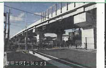
写真②:名鉄名古屋本線立体交差(整備後)
