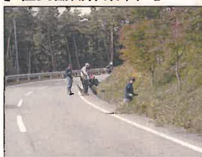
法面の下草刈り
