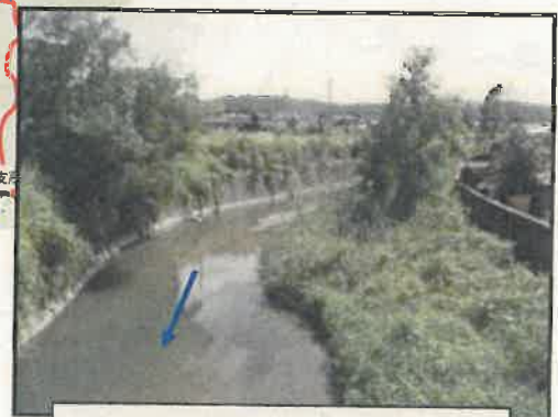
①未改修区間 (石仏橋上流)
