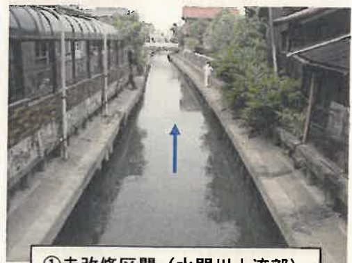
①未改修区間 (水門川上流部)
