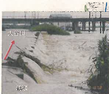
H14.7豪雨 浸水状況
