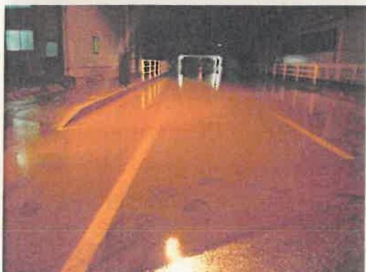
H19.9豪雨 浸水状況
