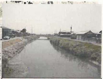
①未改修区間 (5.5km 付近)
