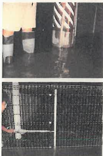
H20.8豪雨 浸水状況
