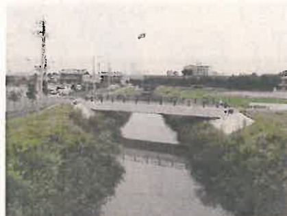
事業実施箇所(7.0km付近)
