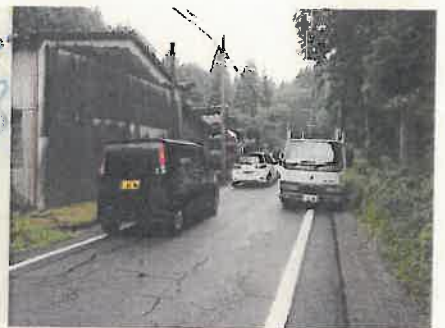
(写真③: 現道状況 / 半道地内)
