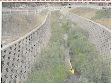
改修後の河道状況
