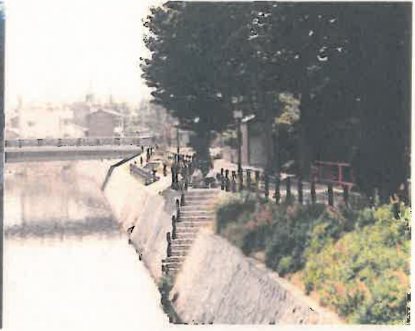
加納大橋と階段護岸
