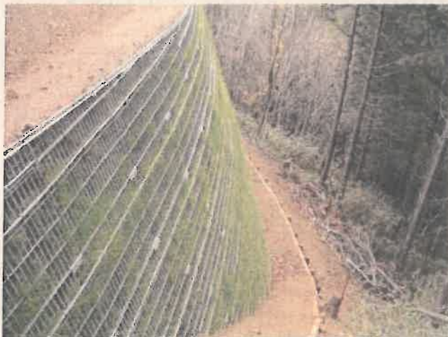
残土の軽減を図る補強土壁工
