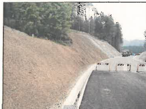
・現場発生木材を利用した法面保護工
