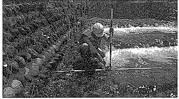
魚道点検状況【実寸測定】(関市：津保川)
