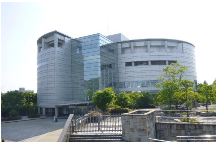
県民文化ホール未来会館外観
