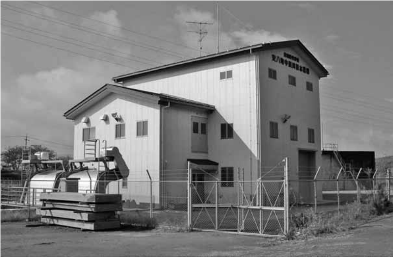
中須川排水機場 (安八町)
