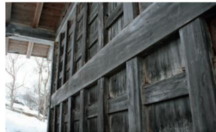
柱と貫の格子に板を落とし込む、「かけづくり」という独特の工法と、腐りにくく堅い栗の木を使うことで長い間、風雪に耐えてきた。
