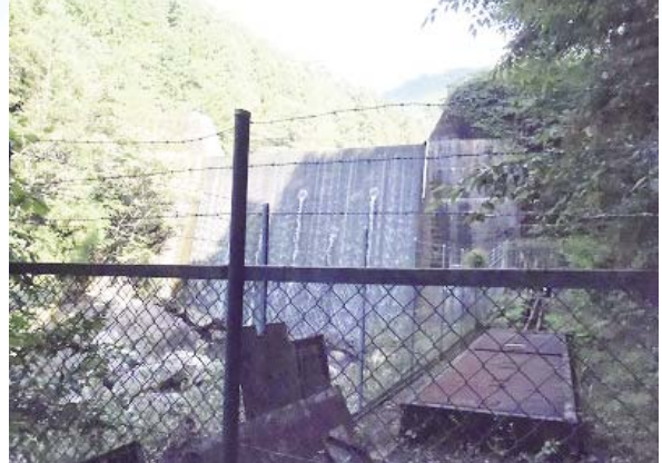
当該森林下流の水道水源の取水施設
