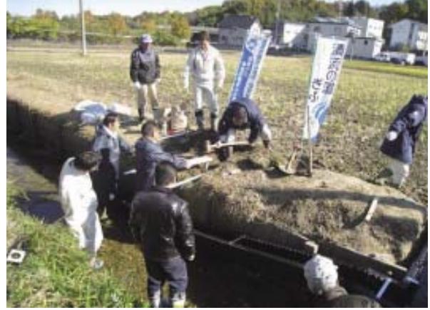
現場研修(参加者による魚道の設置)
