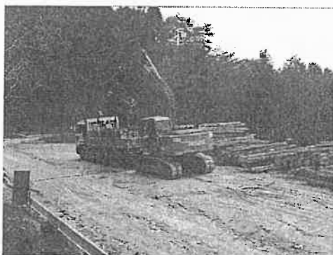
木材生産を促進する林道
