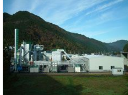
森の発電所（森林資源活用センター）
