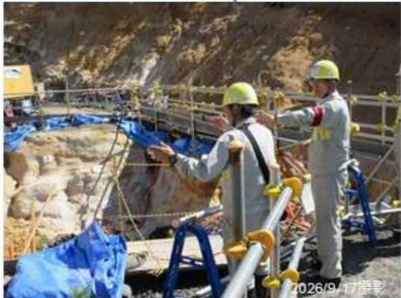
現場の状況を確認する発電所長(右側)
