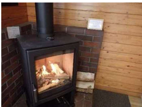
保健・医療関連施設に導入された薪ストーブ （高山市）
