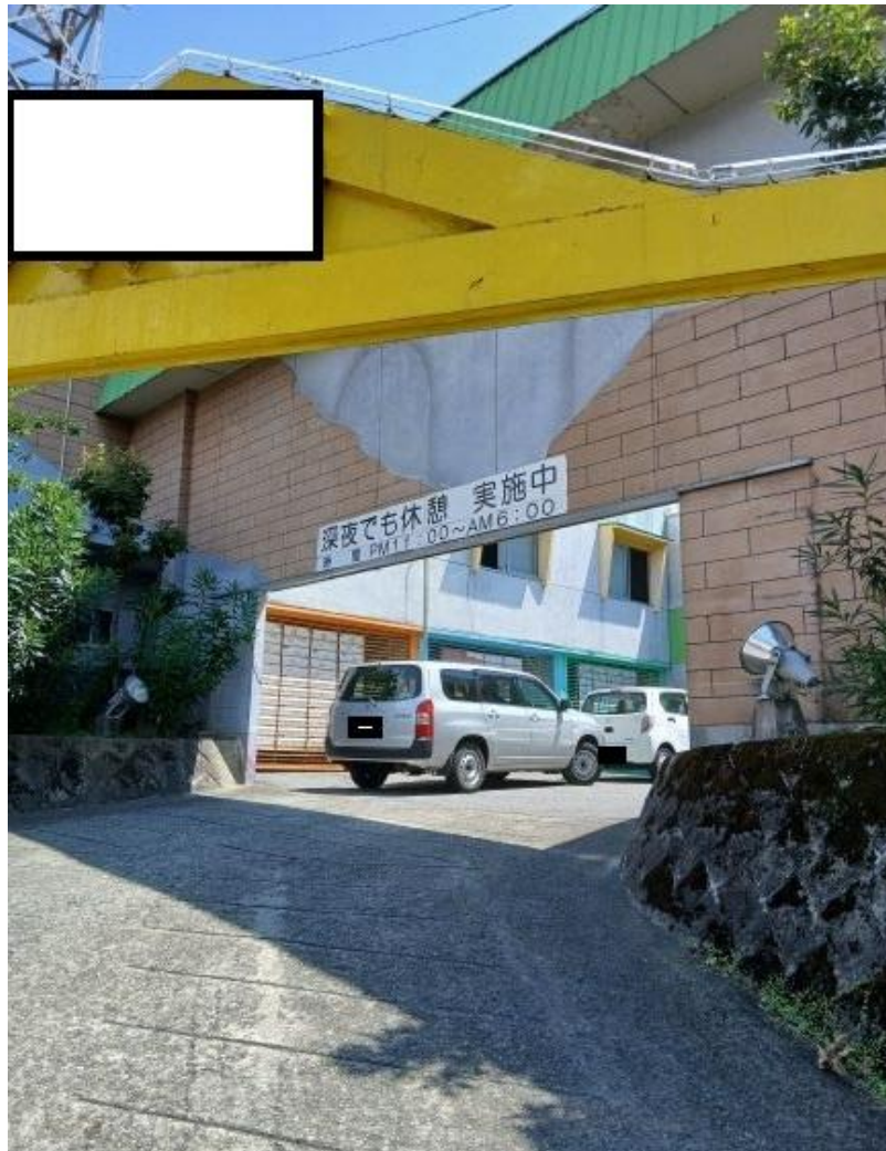
車庫（入口より撮影）
