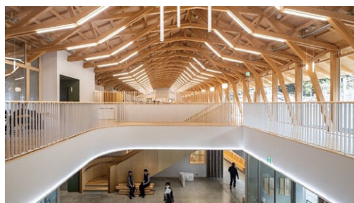
<東濃松のトラス天井>
