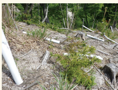
(写真③) 雪で支柱が折れた単木保護資材 (写真)
