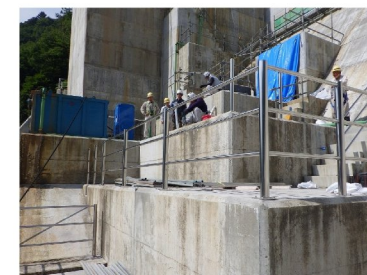
フーチング手摺設置
