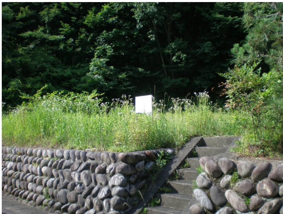
物件南東方向から北西方向を撮影
