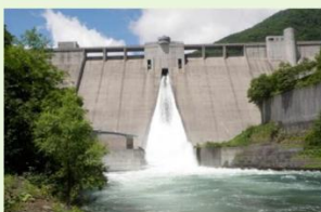
札内川ダムのフラッシュ放流
