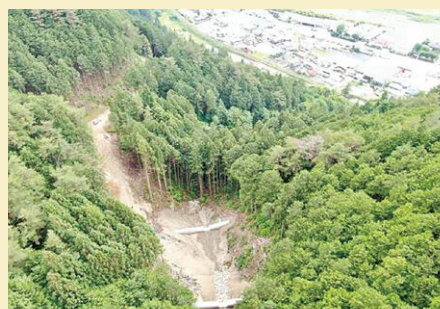
（治山工事の部 - 金子工業株式会社）
