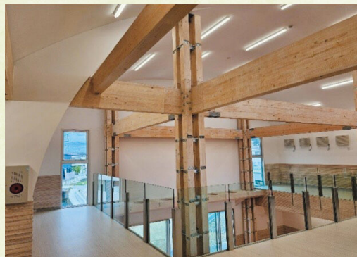
現し梁や柱が特徴の遊戯棟内部
