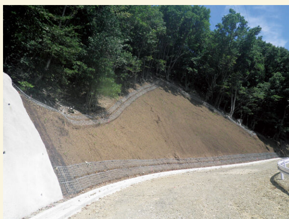
金属柵の設置状況
