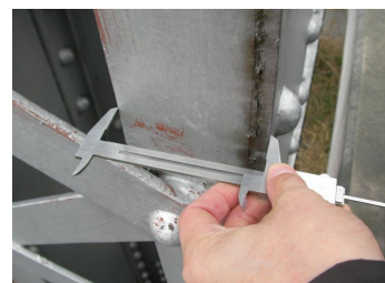
はらみの計測状況
