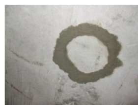
⑨断面修復材充填完了
