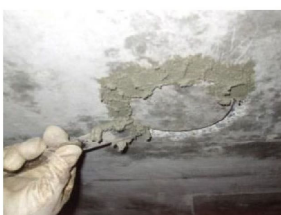
⑧断面修復材充填 左官作業
