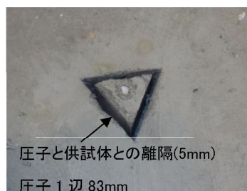
⑤発泡型枠の撤去
