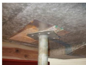
②復旧コア仮受け
