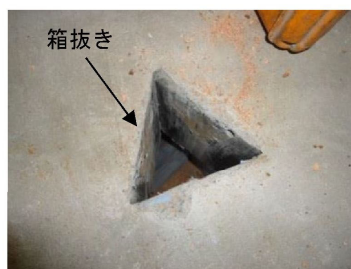
②箱抜き型枠の撤去
