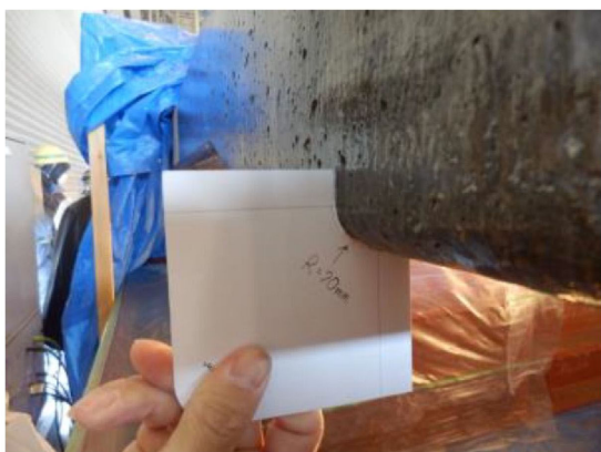
(a) 角部面取り状況
