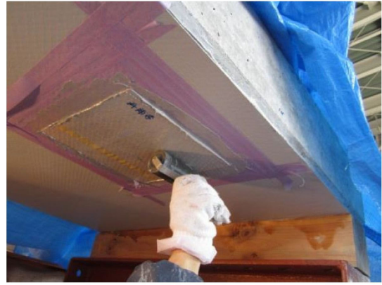
(b) 切り欠き部に対する施工(補修)
