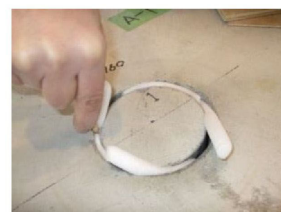
③離隔調整材(φ13mm) 上面側より1重目設置
