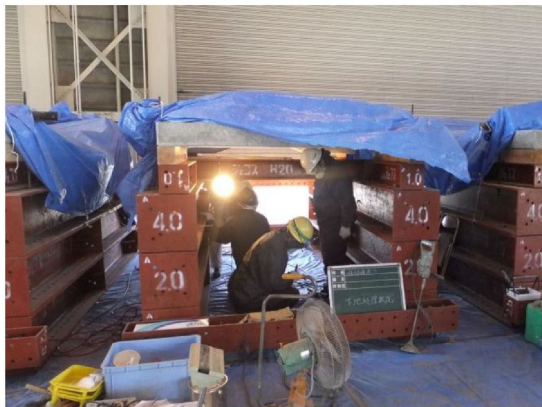
(a) 施工状況（架台設置）
