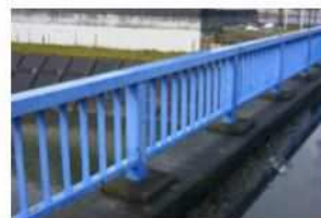
⑥鋼製高欄
