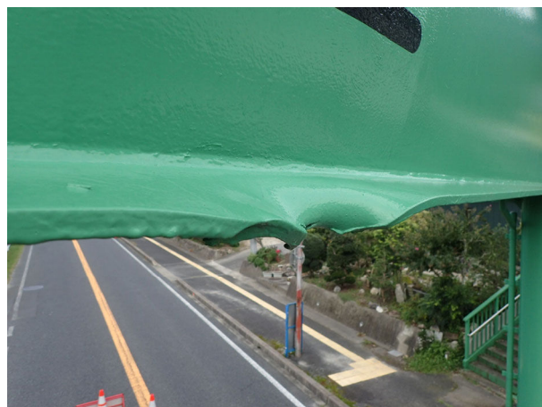
下フランジの大きな変形、亀裂
