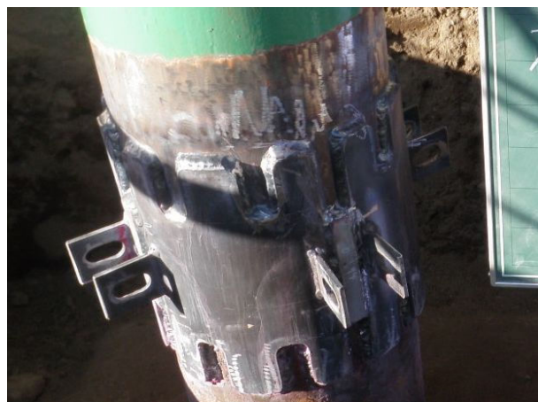
当て板による補強
