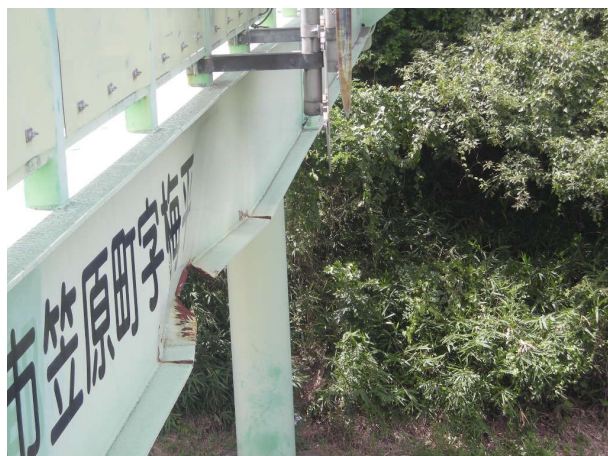
下フランジの大きな変形、亀裂
