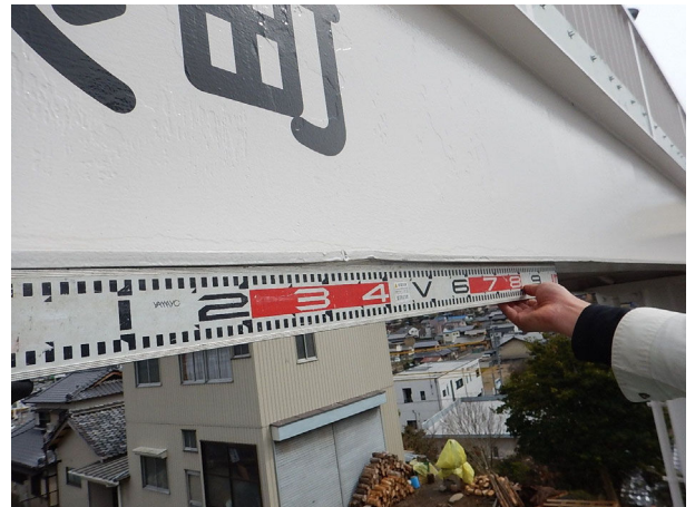
下フランジの軽微な変形
