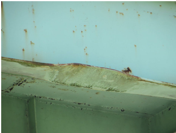
下フランジの軽微な変形
