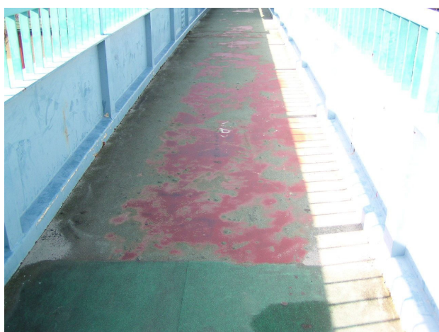
上部構造の床鋼板の露出
