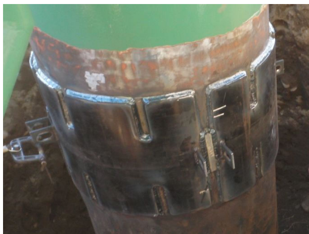
当て板による補強
